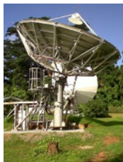
SBC06 Vertex 7.2m Ku-Band ABS-2A SEA
